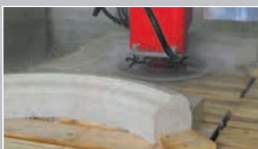
6. Spatulatura con disco orizzontale Profiling with shoulder of blade horizontally Balayage au disque horizontal Rebaje con disco Horizontal
